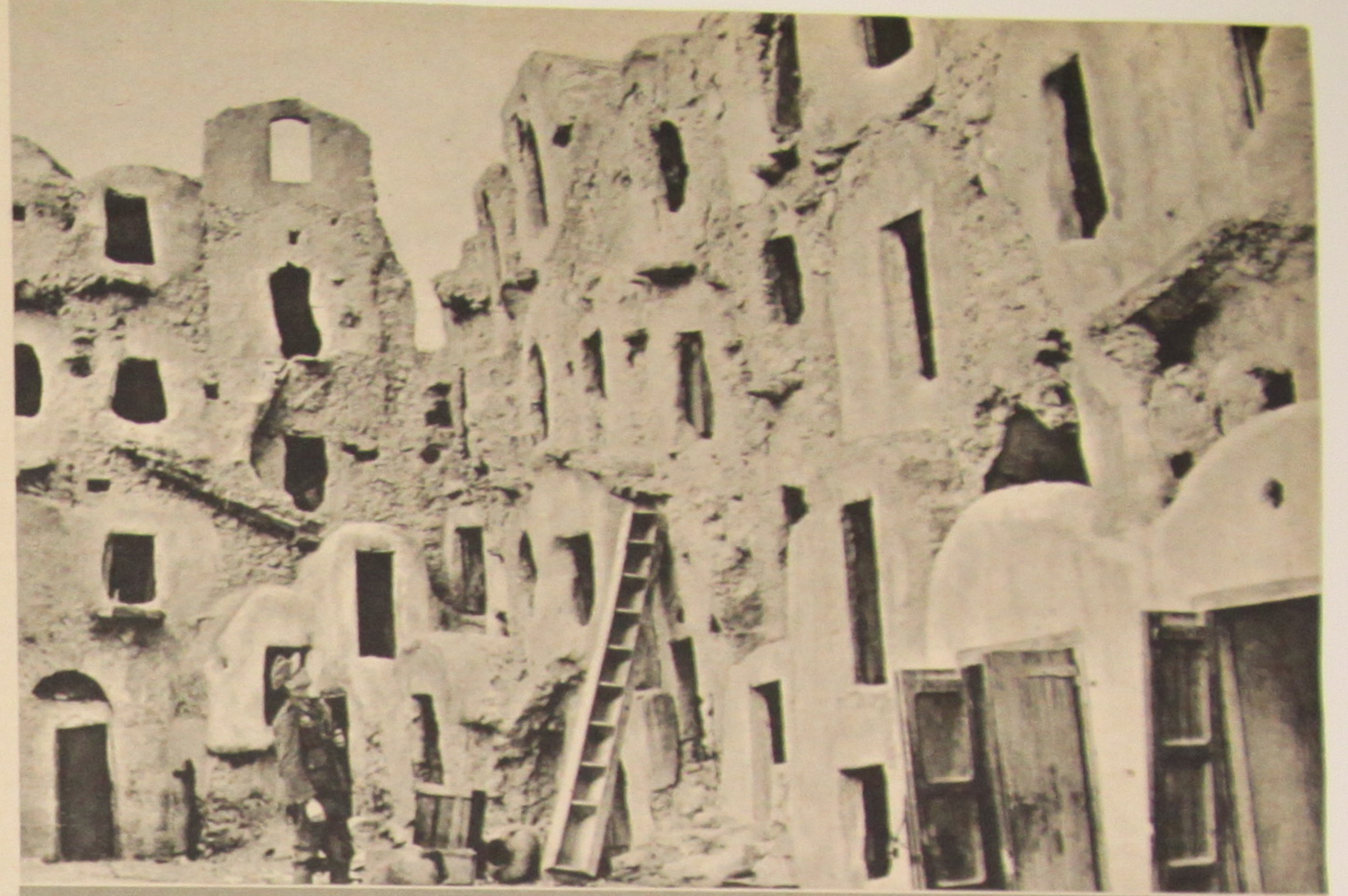
Stunnenlang stehen unsere Soldaten vor den Fassaden einer „Straße“ in H. Für große Teile des westlichen Nordafrikas ist die Bauweise, übrigens eine typisch städtische, kennzeichnend. Regelmäßig sind die einzelnen Stockwerke übereinandergelagert und nur von außen durch treppenförmige Stufen zu erreichen. Die Araberstadt, von der unsere Aufnahme einen kleinen Ausschnitt zeigt, ist übrigens von den Einwohnern verlassen, daher der ruinenhafte Eindruck
