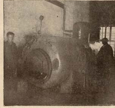
Kotłownia i ślusarnia.
