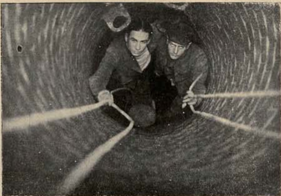
Rozbudowa polskiego Manchesteru: Jak wiadomo Łódź nie posiada do tej pory należącej sieci kanalizacyjnej. Dopiero w ostatnim czasie magistrat miasta Łodzi postanowił przeprowadzić kanalizację w wielkim stylu. Na ilustracji powyższej widać robotników, zajętych przy budowie kanału podziemnego.
