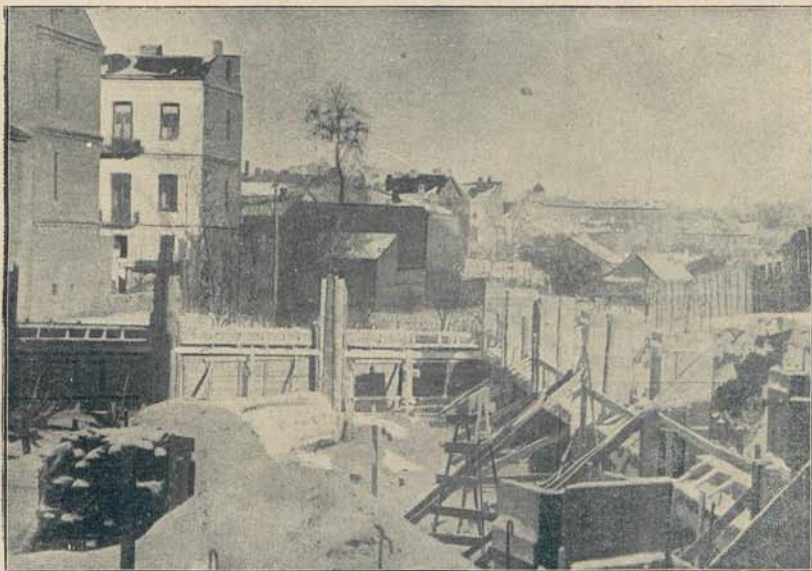
Strona północno-zachodnia fundamentów Domu Ludowego w Białymstoku. Fot. am. E. Motylewski.
