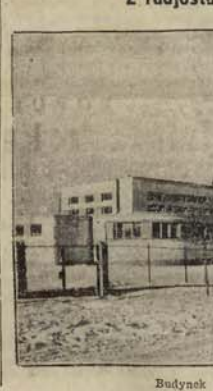
Budynek stacji nadawczej.
