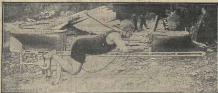
Wzrost i taniec wynalazków najnowszych, wyprobowanych na Sekwanie pod Paryżem przed kilku dniami przedstawia nasza rycina. Jest to jakby rower do pływania. Pływak, krecząc nogami pedały, uprawia w ruch rodzaj malej śruby okrętowej, steruje zaś rękami.
