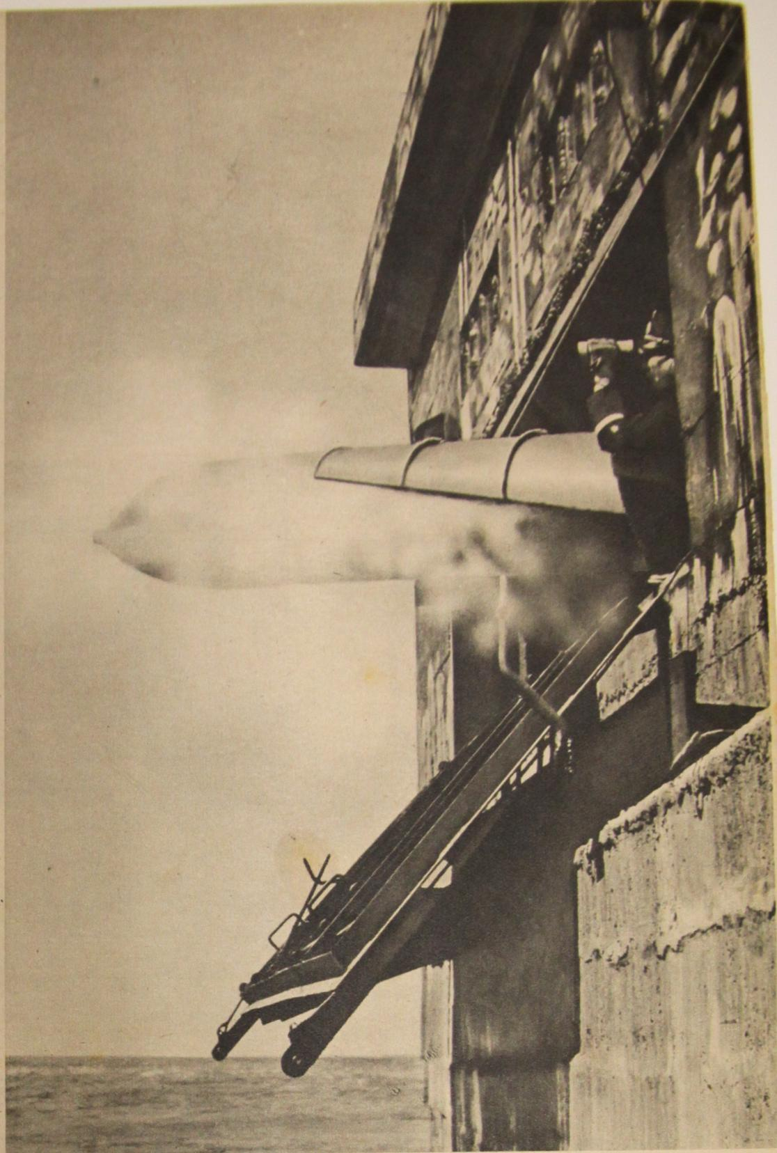
Rohr los! Mit einer Pulverladung wird der Torpedo aus dem Rohr hinausgeschleudert. (Bei Unterwassertorpedos wird komprimierte Luft zum Ausstoßen des Torpedos verwendet)
