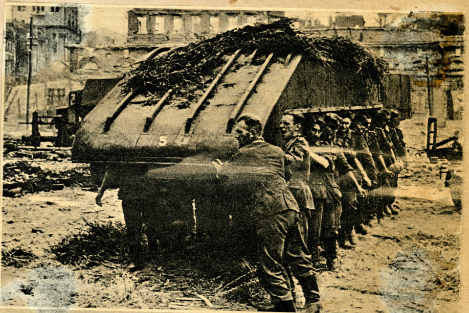
Pioniere an das Don-Ufer herangezogen werden. Pontons werden zu Wasser gebracht, um zu Fähren zum Übersetzen auf das andere Don-Ufer zusammengesetzt zu werden
